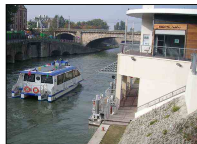
Appontement à la station de métro Corentin Cariou
